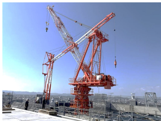
クレーン撤去施工状況（手前が13tクレーン）
